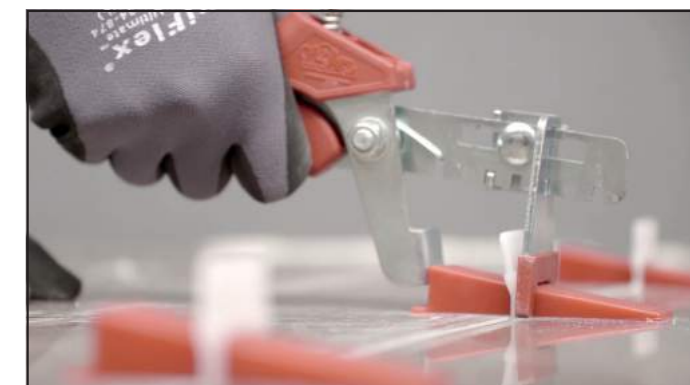
Utilizzare distanziatori livellanti per garantire complanarità delle lastre.
