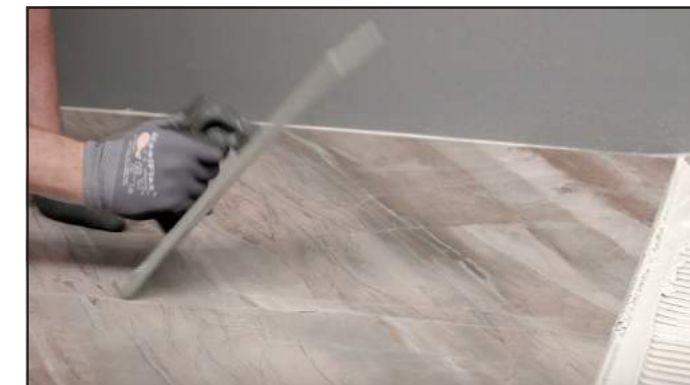
Battere con attrezzo dal centro all'esterno della lastra per compattare adesivo ed evacuare residui d'aria.
