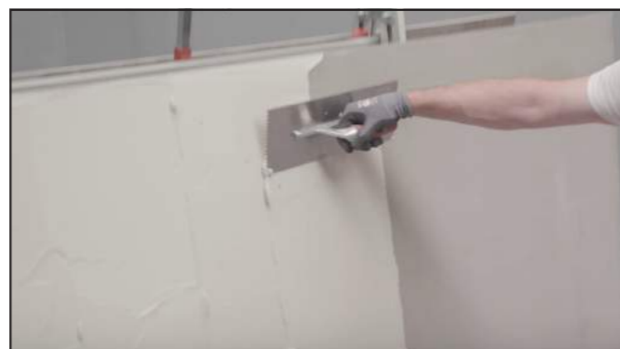
Stendere l'adesivo parallelamente al lato corto lastra, con spatola a denti dritti da 3 mm.
