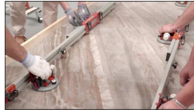
Consigliato telaio in alluminio con ventose a vuoto controllato.
