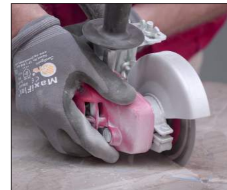
Per tagli a L o C realizzare fori ai vertici interni dell'area da rimuovere e procedere con il taglio.
