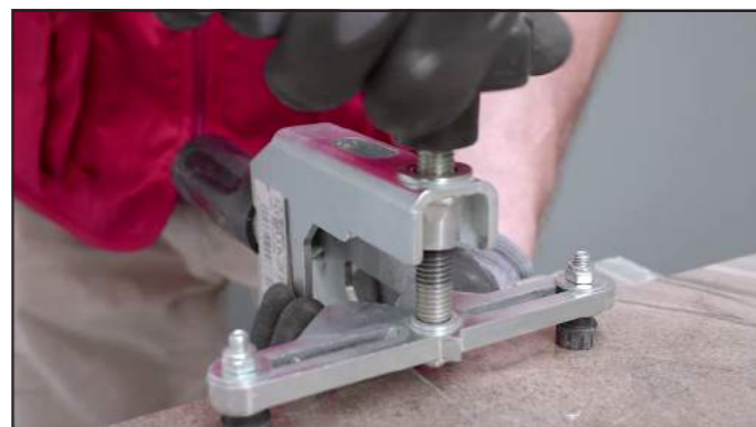
Procedere con spacco tramite apposita pinza troncatrice.
