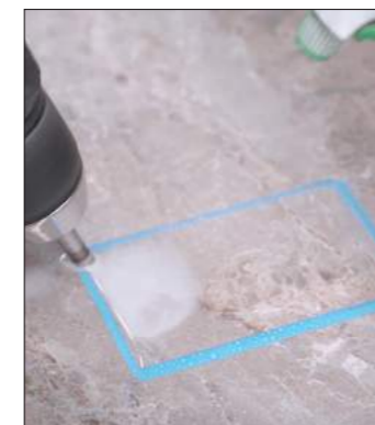
Per fori rettangolari prevedere fori con fresa diamantata in corrispondenza dei vertici del disegno del rettangolo, prima del taglio con smerigliatrice. Per la realizzazione dei fori compiere movimento rotatorio senza esercitare eccessiva pressione e mantenendo bagnata la superficie.
