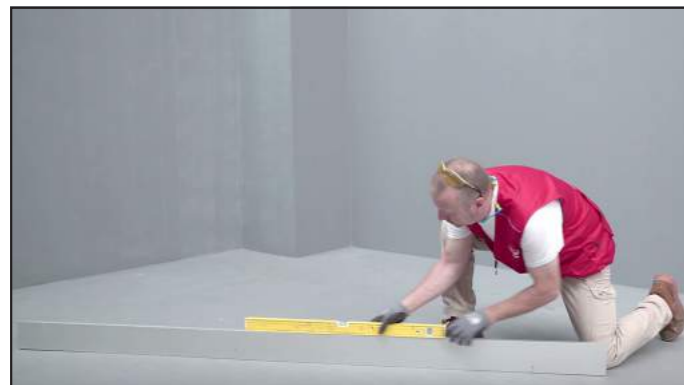
Verificare pulizia e planarità del sottofondo.
