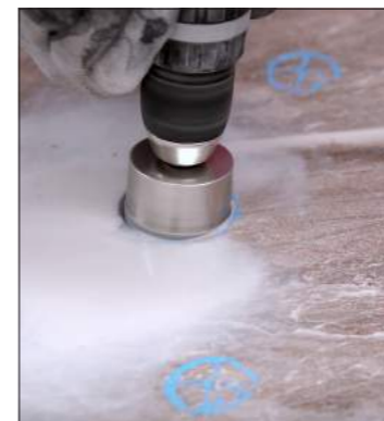
Per fori circolari utilizzare fresa diamantata di diametro variabile in funzione della dimensione dei fori.
