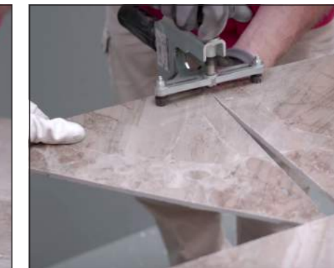
Per tagli a L o C realizzare fori ai vertici interni dell'area da rimuovere e procedere con il taglio.
